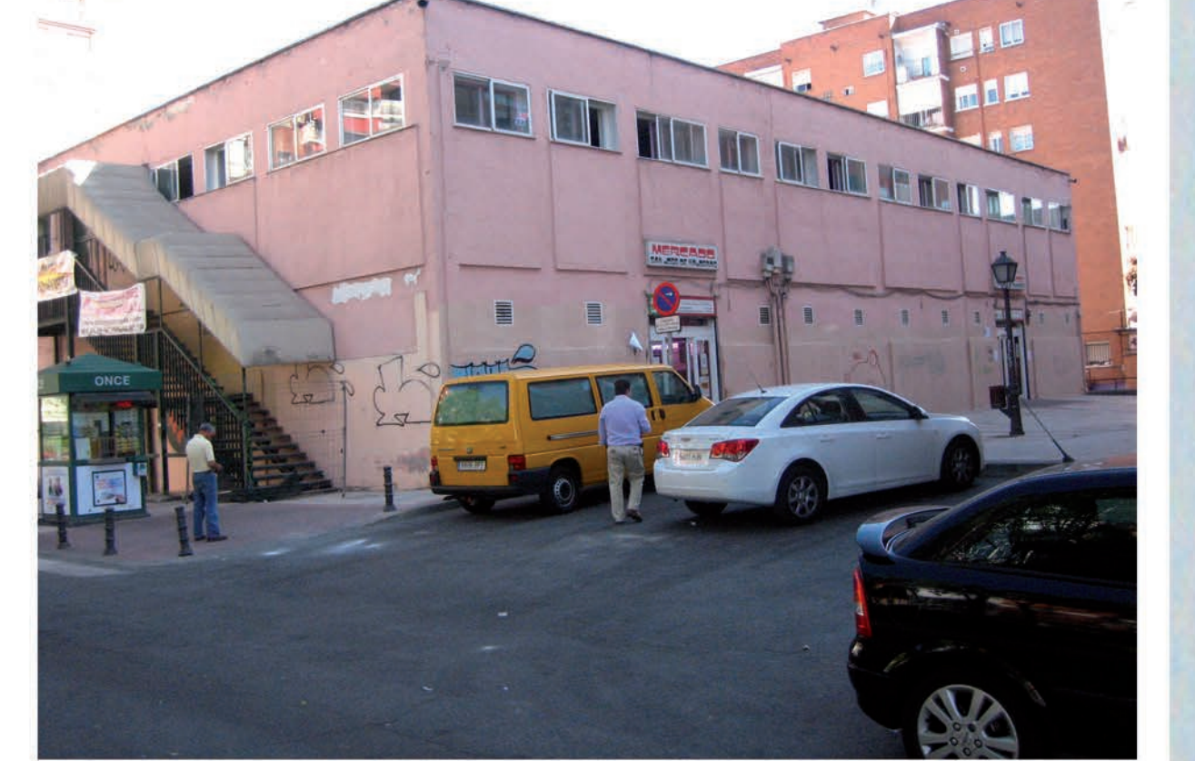
ESTADO ACTUAL DEL MERCADO DE SAN JOSÉ DE VALDERAS
